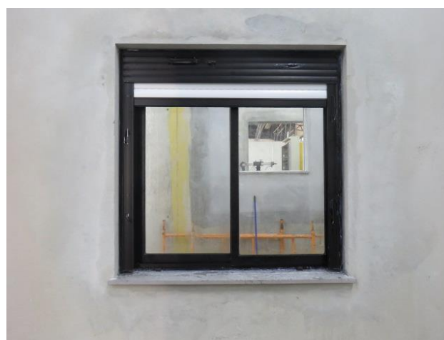
Figura 2 – Vista externa da esquadria instalada
