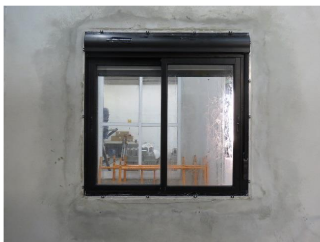
Figura 1 – Vista interna da esquadria instalada
