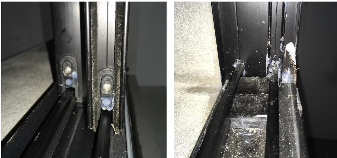
Figura A.3 – Detalhes das escovas e silicone utilizado para vedação
