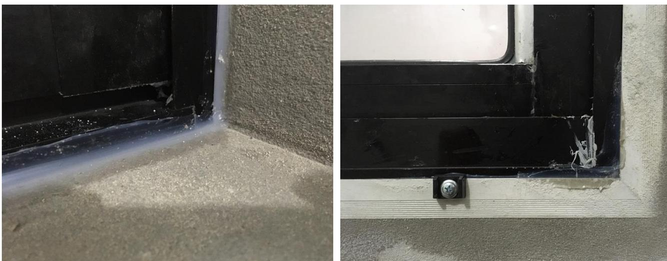
Figura A.4 – Detalhes da vedação entre marco e alvenaria
