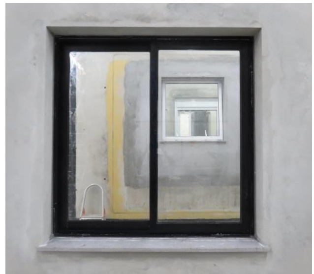
Figura 2 – Vista externa da esquadria instalada
