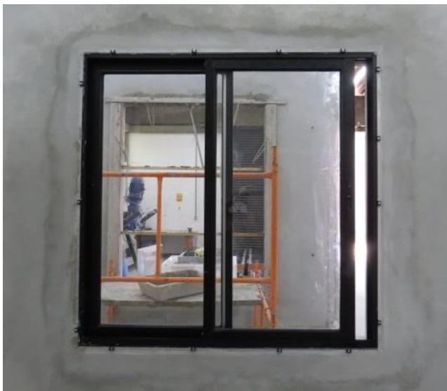
Figura 1 – Vista interna da esquadria instalada
