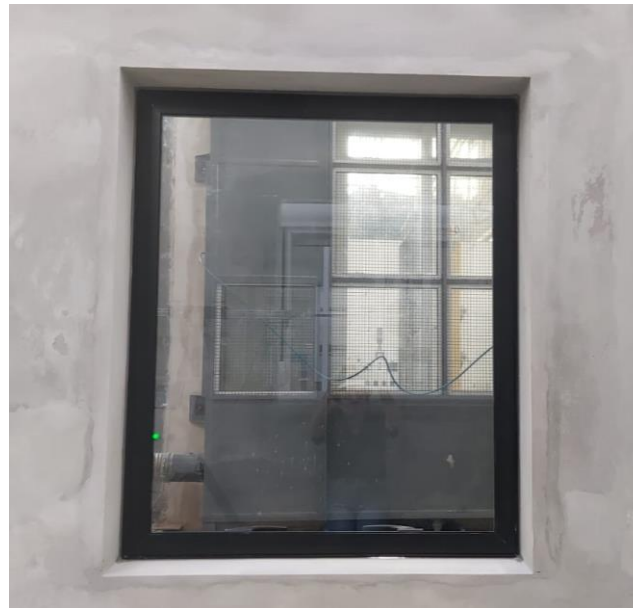
Figura 2 – Vista externa da esquadria instalada
