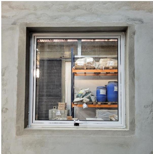
Figura 1 – Vista interna da esquadria instalada
