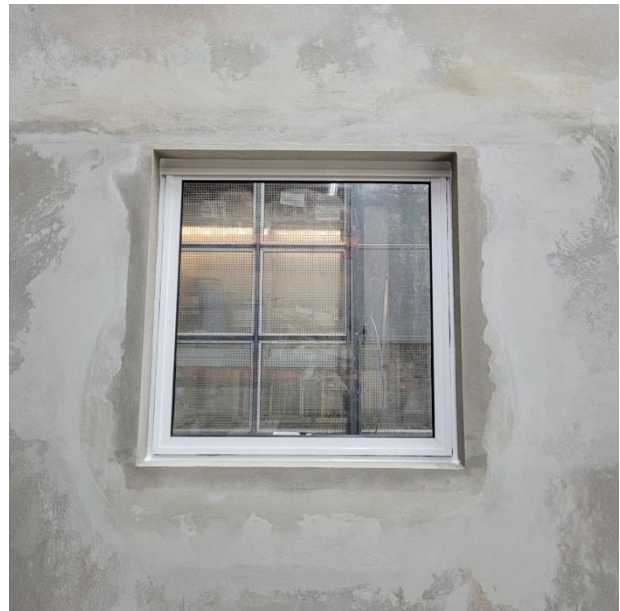
Figura 2 – Vista externa da esquadria instalada
