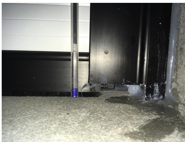
Figura A.5 – Detalhes (a) do perfil e fitas de vedação e (b) do fecho da janela
