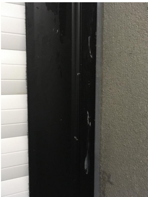
Figura A.4 – Vedação entre marco e alvenaria com silicone
