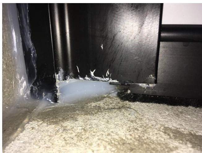
Figura A.5 – Detalhes (a) do perfil e fitas de vedação e (b) do fecho da janela
