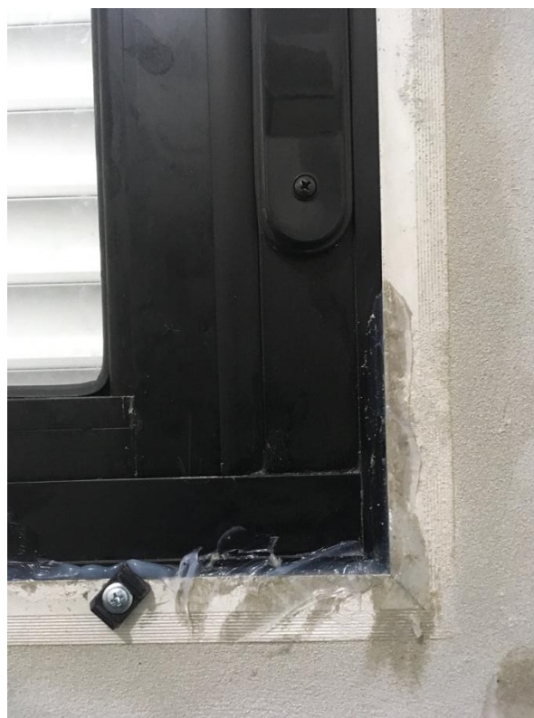
Figura A.4 – Vedação entre marco e alvenaria com silicone
