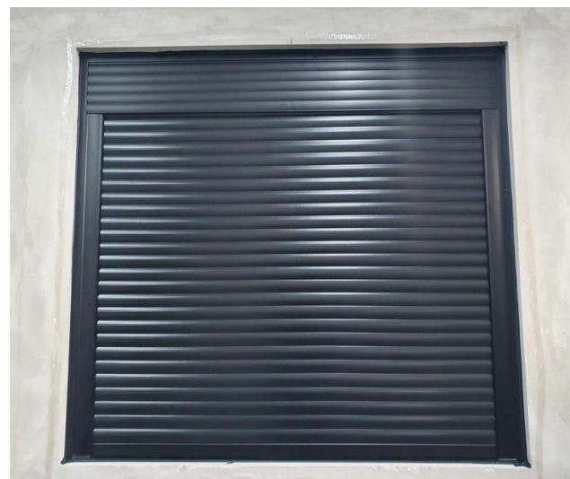
Figura 2 – Vista externa da esquadria instalada
