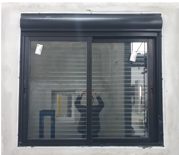
Figura 1 – Vista interna da esquadria instalada
